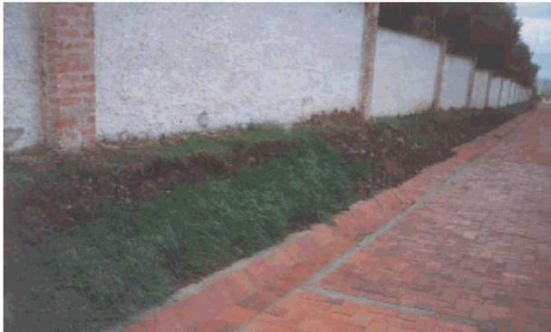
Figura 10. Estado final del talud intervenido (70 días después de colocado el biosólido (proporción 50% 50%).
