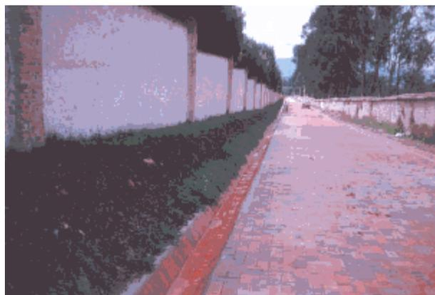
Figura 9. Aplicación del biosólido en el talud (espesor 5 cm.) y crecimiento a los treinta días.
