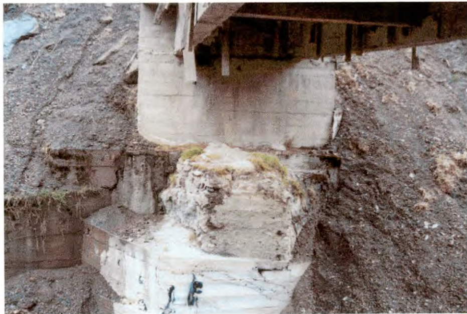
Foto 17 – Estructura de protección margen Izquierda
