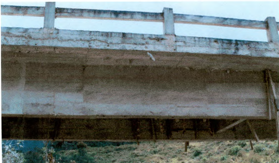
Foto 13 Vigas de concreto de la superestructura existente
