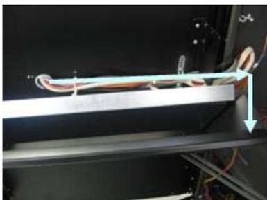
10. Soltar las bridas tapa cables y cablear tal y como indica la figura.
