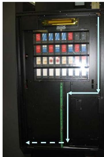
9. Seguir cableando como se indica pasando y sujetando el cable por las bridas como indica la figura.
