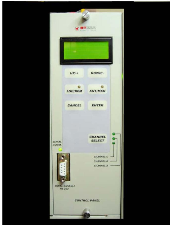
Seleccionado un canal o el propio controlador, se muestran las características más importantes. Incluso se pueden modificar algunos de los parámetros de los equipos, seleccionando el canal y parámetro concreto y modificando el valor con las teclas up o down.
