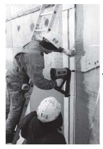
► El material RedLINE se afianza al substrato de concreto con barras de terminado. Esta fijación es necesaria para alturas superiores a 4 pies [1.2 m].
