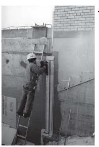
← El material RedLINE se afianza al substrato de concreto con barras de terminado a lo largo de su altura.
