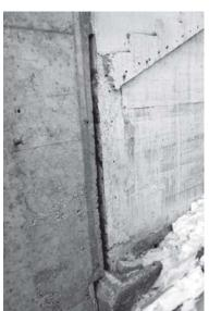
Hendidura de la junta de expansión en la pared del cimiento.
