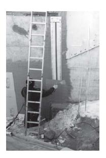
Instalación completa RedLINE con material de poliuretano rociado.
