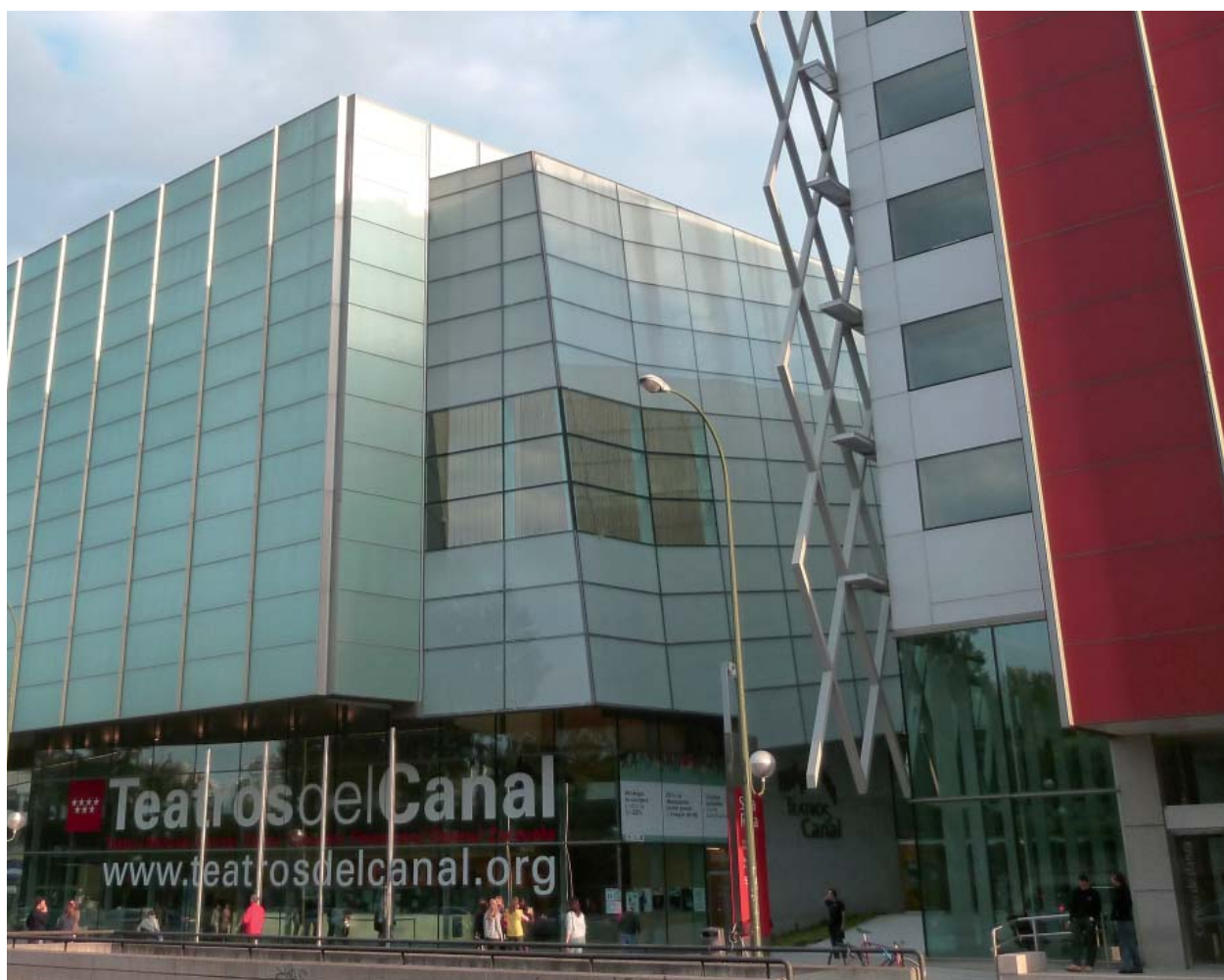
Instalación compensada por CYDESA. Teatros del Canal (Madrid)
