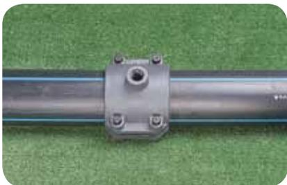
6. Instale sobre este un registro de incorporación y con un taladro para acometidas, perfore sobre la tubería el orificio de salida.
