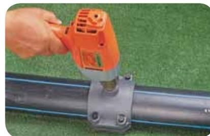
NOTA: (En el paso 6) Se puede usar un sacabocado sin dañar la Tubería.
