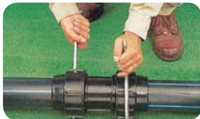
NOTA: Los ensambles de estos accesorios a las tuberías de polietileno son iguales en uniones, adaptadores macho y hembra, tees y codos.
