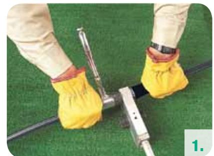
2. Una vez finalizado el ciclo de calentamiento separe el tubo y el accesorio de las caras de calentamiento con un movimiento rápido, extraiga la plancha y comience la unión del accesorio y el tubo (esta operación debe hacerse como máximo en 5 segundos).
