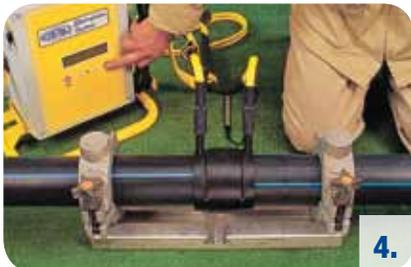
5. Durante la misma; se notará un movimiento ascendente de los “Testigos de Fusión” (Fideos de polietileno fundido) del accesorio. Estos no deben ser alterados bajo ningún concepto.
