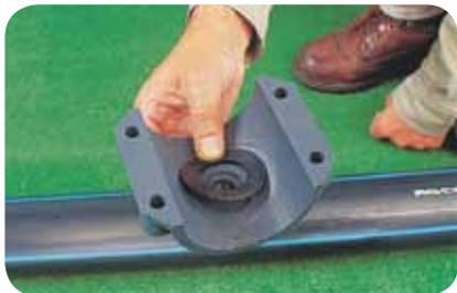
2. Colóque la parte superior sobre la tubería alineada.
