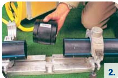
3. Ubique el tubo en el dispositivo con mordazas de alineación, con el accesorio colocado hasta el tope. "No force más allá del tope". Ajuste las mordazas.
