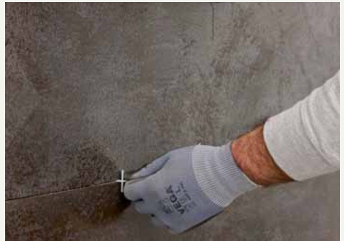
fig.37 /Junta con espaciadores. /Rejunte com espaçadores.
