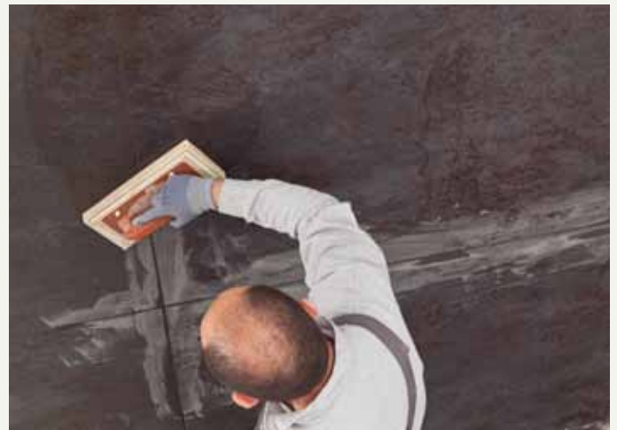
fig.39 /Rejuntado. /Aplicação de estuque.
