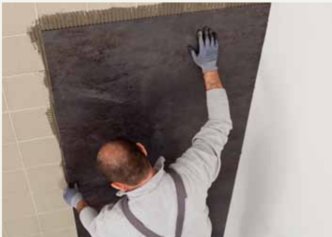
fig.38 /Colocación de la placa. /Assentamento da placa.
