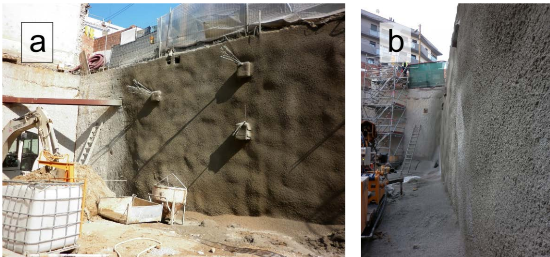
Fig. 66 - Foto del acabado final del proyectado en los muros Bi-Capa
