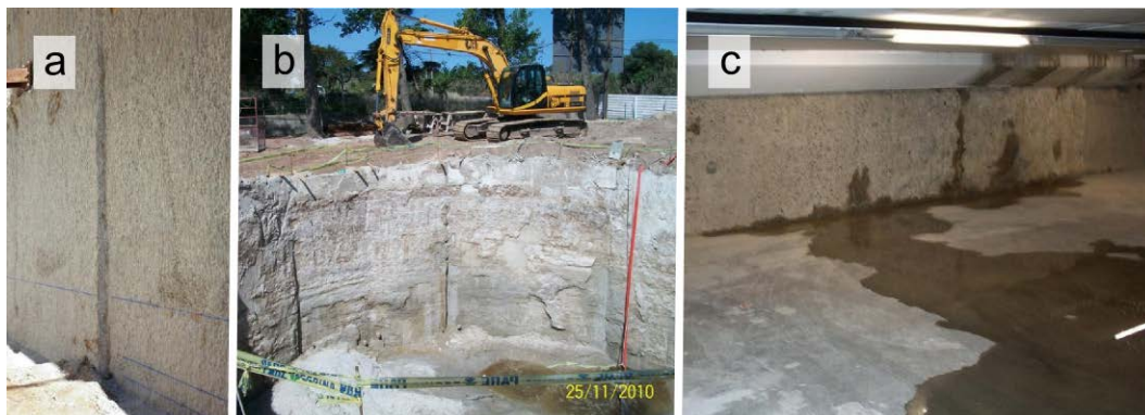
Fig. 55 - Defectos usuales en pantallas continuas: a- Diferencias de posición entre bataches adyacentes, b- Pérdidas entre juntas durante construcción, c- Pérdidas que aparecen ya en servicio
