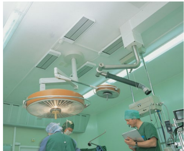
Utilizar paneles radiantes EZ200 para calentar una estancia resulta extremadamente higiénico, ya que no provocan ningún movimiento de aire.
