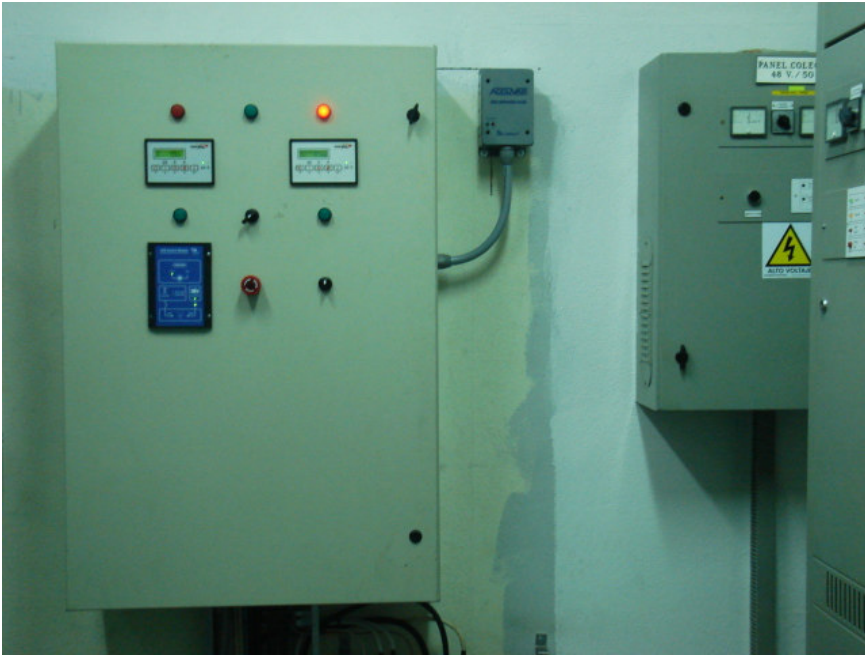
Figura 34. Transferencia dual utilizando módulos de control Murphy AS731.
