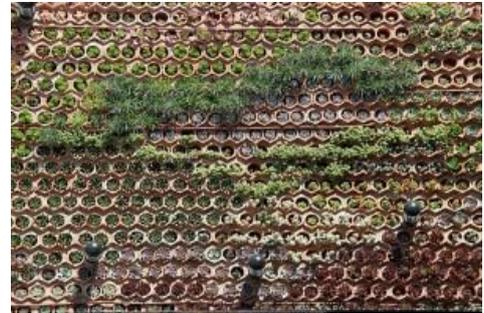
valor añadido cada uno de los huecos actúa como un elemento anecoico, la configuración del jardín, el sustrato y la vegetación colaboran a la hora de convertir en este sistema en una barrera de absorción acústica.
