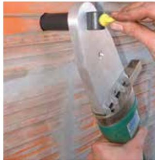
**5.** A continuación se calienta la montura de reparación durante 15 segundos sin retirar la boquilla del tubo. Sumando los tiempos de calentamiento 10 s + 15 s, el calentamiento total del tubo alcanza los 25 segundos.
