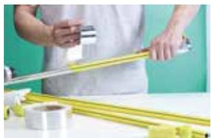
**3.** Una vez cubierto cada accesorio, la protección anti UV continuará con el resto de la tubería. A tal efecto, la cinta se aplicará en forma helicoidal sobre los caños, tratando de que cada vuelta monte o solape sobre la anterior vuelta en por lo menos un cuarto del ancho de la cinta.
