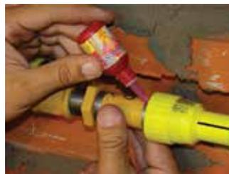
**5.** Colocando selladores aprobados, enroscar la conexión completa a la transición hembra, por el extremo de rosca más corto (el que no contiene cupla y tuerca).
