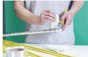
**4.** En los encuentros de tubos y accesorios, la aislación de los tubos deberá avanzar hasta cubrir la protección aislante del accesorio previamente encintado. Una vez cubierto el accesorio, no se requiere una segunda protección total, es suficiente con el encintado previo más la solapa que se forma en cada encuentro de tubo y accesorio.
