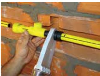
**3.** Desarmar el conjunto y fusionar el Te (ya unido a la transición hembra) a la tubería existente.
