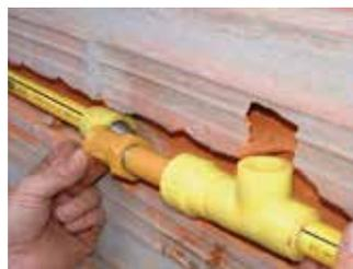
**6.** Mover la tubería con la transición hembra fuera del tabique. Alinear la tubería, poner sellador en la rosca de la transición macho y enroscar la cupla. Agregar sellador entre la cupla y la tuerca y ajustar.
