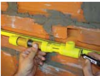
**1.** Armar fuera de la canaleta el conjunto: Te + transición hembra + conexión completa. El Te y la transición hembra se unen fusionando entre ambos un trozo de tubo del largo deseado.
