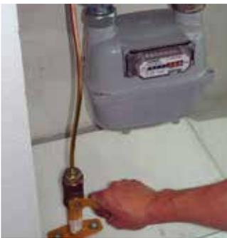
**1.** Si la cañería está bajo carga hay que cortar el suministro de gas a la vivienda, cerrando la llave de paso de entrada al edificio. Previamente hay que asegurarse de que todos los artefactos estén apagados.
