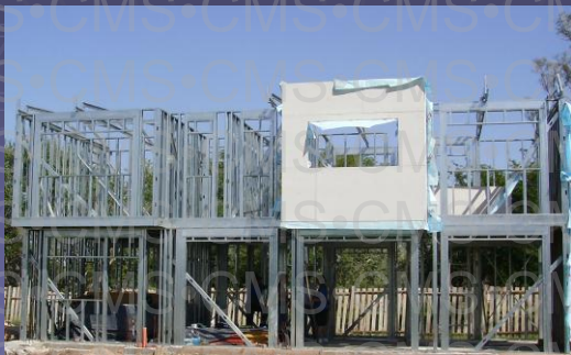
En obra: Paneles Vista Contrafrente
