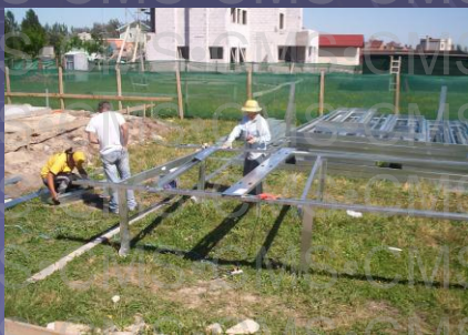
Secuencia del sistema Armado de Paneles
