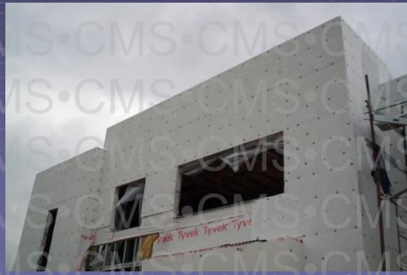
Secuencia del sistema Revestimiento exterior con aislación térmica
