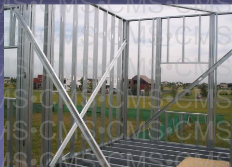
Secuencia del sistema Montaje estructura
