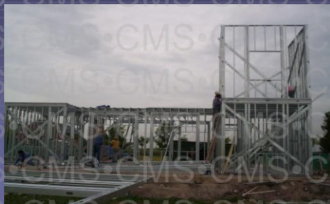
Secuencia del sistema Montaje estructura
