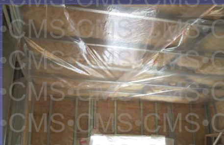
Secuencia del sistema barrera de vapor
