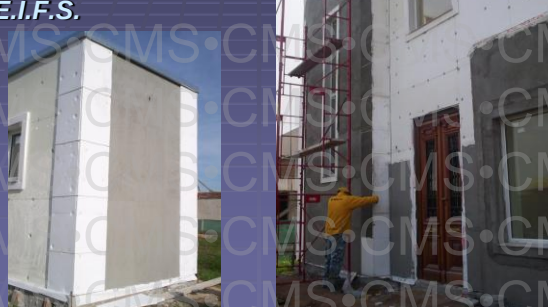
Secuencia del sistema Revestimiento exterior con aislación térmica
