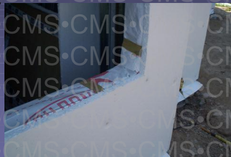
Secuencia del sistema Revestimiento exterior con aislación térmica
