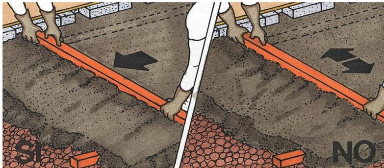
Luego de colocada la capa, se retiran los rieles y se llenan sus huellas, con cuidado, con arena suelta. Se debe corregir cualquier daño o imperfección, soltando la arena con un rastrillo y enrasando
