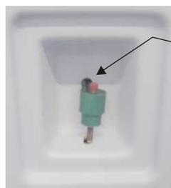
**Conmutador de alta presión situado dentro del panel sobre el lado derecho del aparato.**
