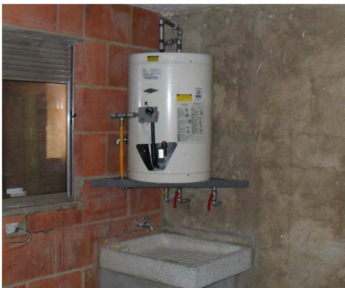
Ilustración 4 Instalación calentador
