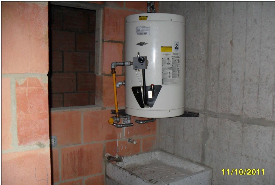
Ilustración 3 Instalación calentador
