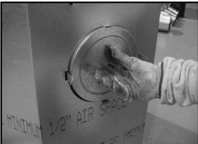
**Figura 7.8** Doble hacia afuera las partes centrales de la banda de retención y utilícelas para retirar la tapa del tubo de escape.
