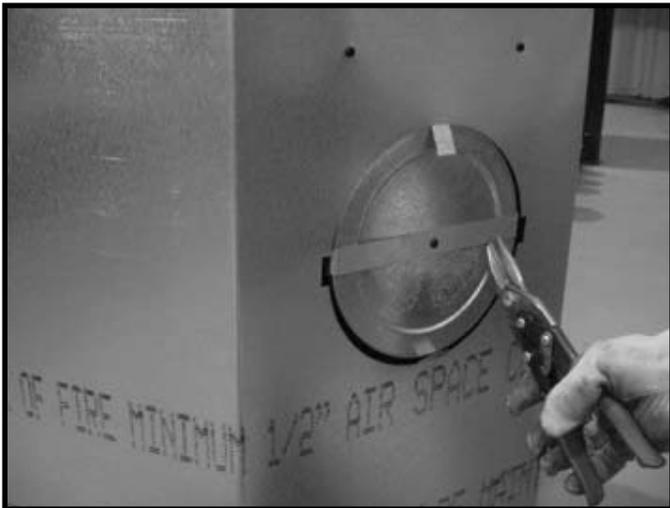
**Figura 7.7** Corte la banda de retención metálica y doble los lados hacia afuera.
