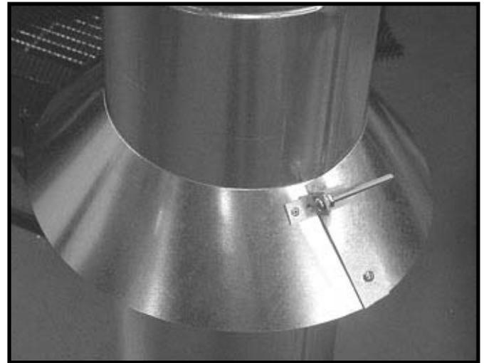
**Figura 8.19** Ensamblaje del collarín para tormentas alrededor del tubo de escape
