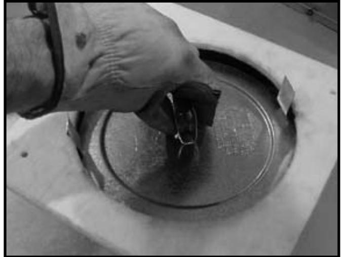
**Figura 7.4** Doble hacia arriba las partes centrales de la banda de retención y utilícelas para retirar la tapa del tubo de escape.
