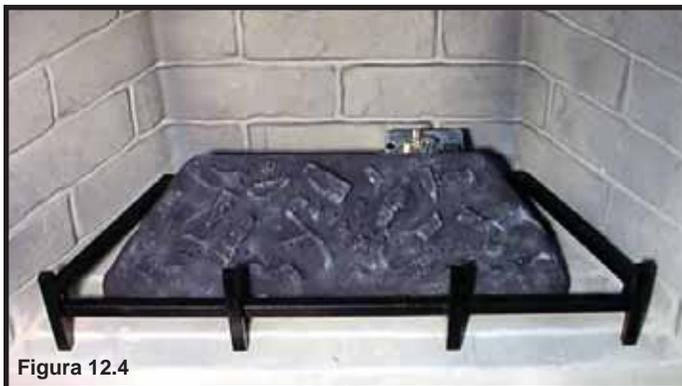
**PASO 2.** Coloque la parrilla sobre la base de la cámara de combustión y alrededor del quemador para que las barras cortas que están en la parte de atrás se enganchen con la parte de atrás del quemador. La parrilla debe estar centrada en la cámara de combustión.
