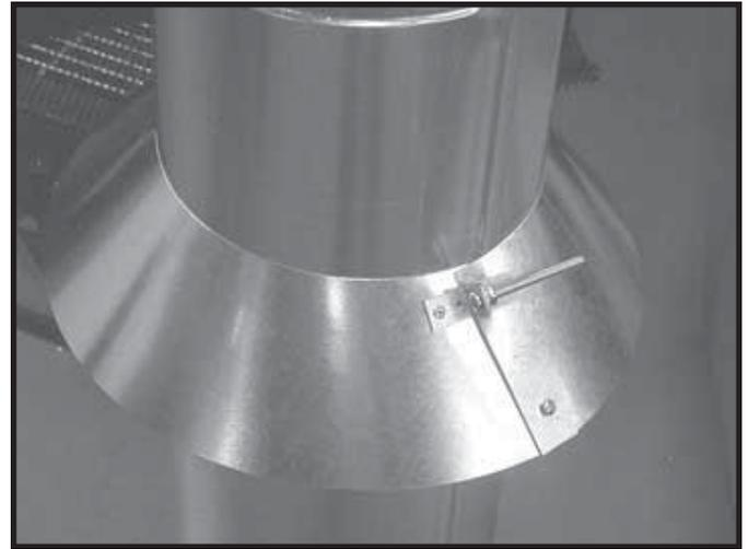
Figura 8.18 Ensamblaje del collarín para tormentas alrededor del tubo de escape
