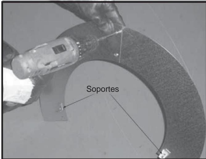
Figura 8.17 Ensamblaje del collarín para tormentas
