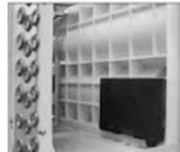
Ilustración B – Extracción del filtro de ventilación
