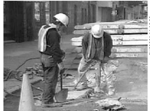
Corte la sección de la tubería que se va a reemplazar de manera que sobresalgan seis pulgadas hacia el interior del foso.
