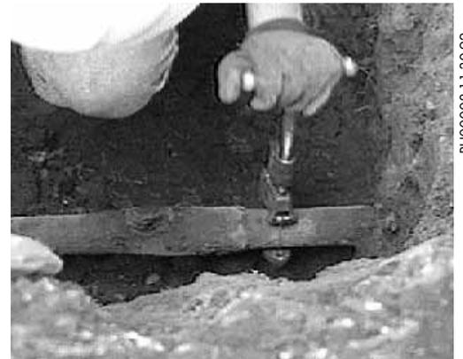
Instale una base de contrachapado de 3/4" en el fondo de la fosa. Cubra el contrachapado con una lámina de neopreno para formar un piso en el que pueda trabajar.
