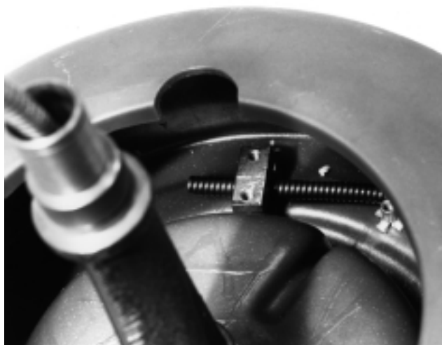
Figure 12 – Positionnement d'un nouveau câble sous le support
