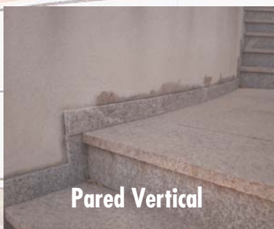
Mal drenaje = Humedad zona transitable
