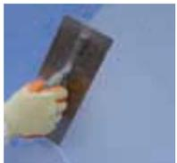
Aplicar **weber.tene micro** en dos manos, con una llana de acero inoxidable en el paño de trabajo de abajo a arriba, apretando el material para regularizar el espesor de la capa. Pasar la llana vertical y horizontalmente varias veces para obtener una capa del material uniforme y sin exceso de material.
