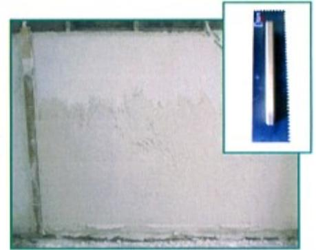
**6. Aplicación de una capa gruesa (acabado) de FLEXIREV.** (Rdto. de las 2 capas =25 Kg/m<sup>2</sup>) llegando hasta la misma altura que la primera capa de **FLEXIREV.**
