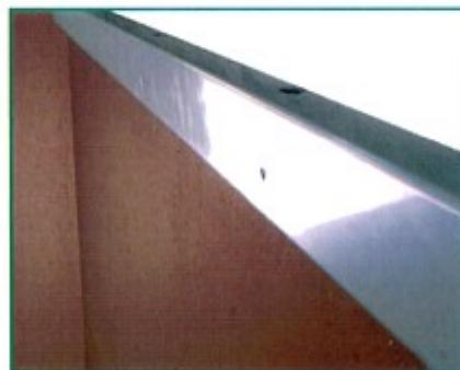
**8. Colocación de la perfilera perforada para rematar la parte superior e inferior,** (perfil perforado, rodapié ventilado, rejillas, ...) de forma que el aire ventile por la pared.
