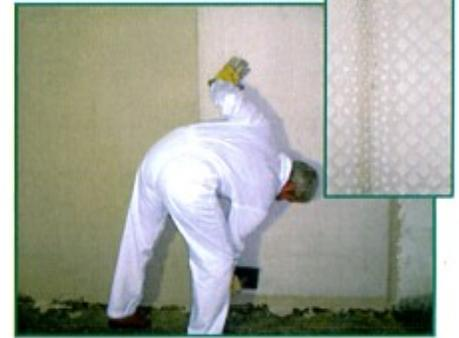
**3. Colocación por adherencia del Platon FLEXI.** Colocar de forma que sobresalga **2 cm. por encima y por debajo del PLAKOL.** Colocar las láminas (antes de que seque el adhesivo) presionando con fuerza y juntando unas con otras (no sobreponiéndolas).
