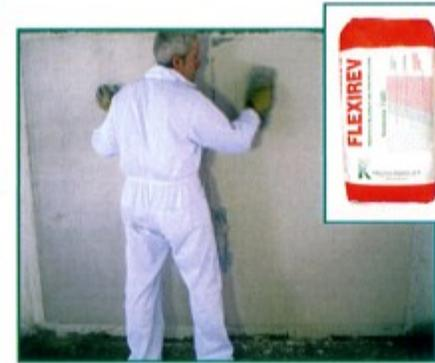
**5. Aplicación de una capa fina (agarre - ver ficha técnica) de FLEXIREV sobre el Platon FLEXI dejando 2 cm. libres de la lámina** tanto en la parte superior como en la inferior. **Proyectar o aplicar a mano** de forma que asegure un buen anclaje al **Platon FLEXI.**
