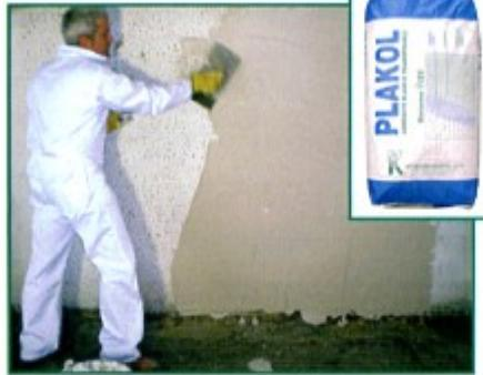
**2. Aplicación del adhesivo blanco transpirable PLAKOL.** (Rdto=5Kg/m<sup>2</sup> aprox. -ver ficha técnica-) Extender la pasta en la pared **dejando 4 cm. libres de adhesivo tanto en el borde superior como en el inferior de la pared** y regularizar el espesor con una llana dentada fina.
