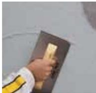
Aplicar **weber.tec hormiestetic** con llana, brocha o rodillo, en capas sucesivas de 1 mm de espesor. El material debe haber empezado a endurecerse antes de aplicar la siguiente capa.
