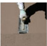
**weber.floor carpeta gris** estará en condiciones de ser transitada en 12 a 24 hs de aplicada. La dureza final se obtiene luego de pasadas 3 semanas de su aplicación.
