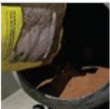
Preparar el material solamente con agua, en trompo o balde, en cantidad de 5L a 6 L por bolsa, según consistencia necesaria. Respetar estas cantidades máximas y mínimas, y mantenerlas constantes en toda la aplicación.
