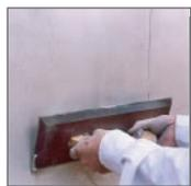
**2.** Aplicar una capa fina de Stuko de 2 mm con un fratás realizando presión.
