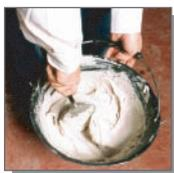
**1.** Se prepara en balde de albañil colocando primero el agua. Usar 11-12 litros de agua por cada bolsa de Stuko Premium, mezclando hasta conseguir una mezcla homogénea y sin grumos.
