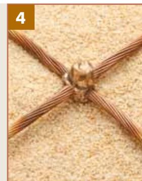
4 Se retiran los selladores para comprobar el resultado siempre con precaución, pues todo el sistema se encuentra a elevada temperatura.
