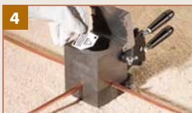
4 Verter el 50% del polvo iniciador a modo de mecha sobre el borde del molde y el resto sobre el compuesto de soldadura. Cerrar la tapa del molde.
