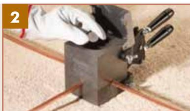
2 Obturar el canal del molde con el platillo soporte.
