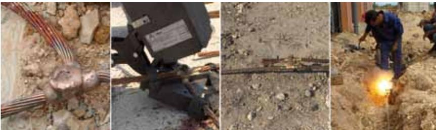
Derivaciones y conexiones entre cables y pletinas
