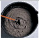
Colocar agua limpia en el balde u hormigonera, luego agregar **weber.tec imper F** paulatinamente (2 lts. cada 7 kg. aprox). Mezclar manualmente o con un batidor eléctrico lento (500 rpm), hasta conseguir una masa homogénea.
