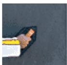
El acabado se puede realizar con fratazo o fieltro según la textura deseada. Puede revestirse con pinturas, revoques y/o cerámicos.
