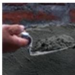
Proyectar con cuchara y reglear. Las fajas de nivel pueden hacerse con el mismo producto hasta lograr un espesor mínimo de 10 mm. Para aplicaciones superiores realizarlo en sucesivas pasadas. La base a colocar debe estar firme, absorbente, y húmeda.
