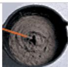
Colocar agua limpia en el balde u hormigonera, luego agregar **weber.tec imper G** paulatinamente (1 lt. cada 7 kg. aprox.). Mezclar manualmente o con un batidor mecánico lento (500 rpm), hasta conseguir una masa homogénea.
