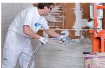
**1** Proyectar sobre el soporte ajustando el caudal de agua para obtener una masa consistente y trabajable.
