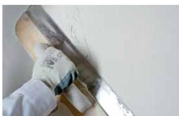
**3** Cortar con una cuchilla de acero para eliminar las pequeñas imperfecciones.
