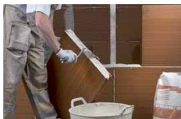
**3** Aplicar el producto con una paleta sobre la superficie que se va a pegar, formando una capa o cordón de espesor homogéneo.
