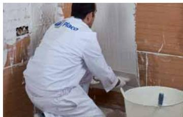
**4** Se aplica con talocha o talochín directamente sobre el soporte, hasta alcanzar el espesor deseado.
