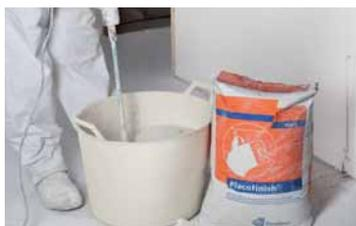
**1** Mezclar el contenido del saco con 14 litros de agua, utilizando el agua y todas las herramientas limpias. Agitar de forma mecánica para conseguir una masa homogénea.
