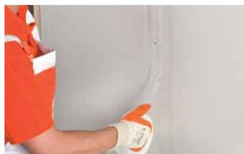
**2** Colocar cinta de malla Placofinish y aplicar posteriormente Placofinish en la junta.
