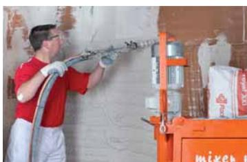
**1** Proyectar sobre el soporte ajustando el caudal de agua para obtener una masa consistente y trabajable.
