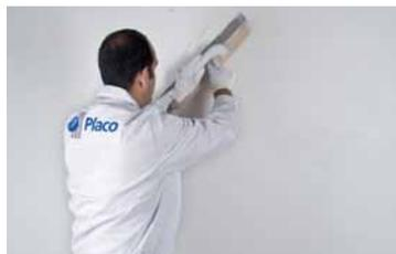
**5** Alisar con regla de aluminio y cortar con cuchilla de acero.
