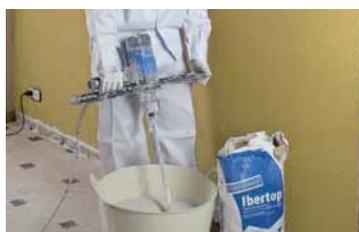
**1** La pared debe estar limpia y preparada para recibir la pasta. En un recipiente de boca ancha se añadirá agua limpia y posteriormente se irá añadiendo el polvo de forma gradual en una relación aproximada de 0,7 litros de agua por 1 kilo de producto y batir enérgicamente.
