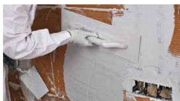
**3** Aplicar directamente con talocha sobre el soporte, hasta alcanzar el espesor deseado.
