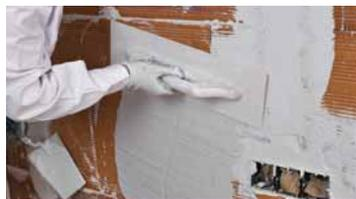
**3** Aplicar directamente sobre el soporte, hasta alcanzar el espesor deseado.
