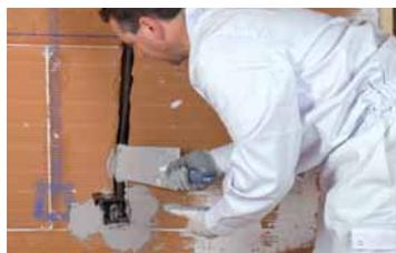
**3** Iberplast se utiliza para la sujeción de instalaciones y elementos auxiliares.
