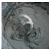
Amasar **weber.rev forte** con apróx. 6/7 lts. de agua limpia por bolsa de 25 kgs. manual o mecánicamente hasta lograr una pasta homogénea y dejar reposar apróx. 10 minutos.
