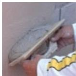
Mojar abundantemente el revoque grueso y dejar orear. Extender uniformemente el producto con frataso de madera en dos manos, hasta obtener un espesor apróx. de 3mm.
