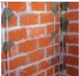
Prepara la superficie y colocar las reglas metálicas. **Aplicación manual:** mezclar con agua limpia ( 12 L de agua por bolsa aprox.). Dejar reposar y volver a mezclar. **Aplicación proyectada:** regular el caudal de la máquina de manera de lograr consistencia de aplicación adecuada ( duo mix aprox. 550 L/hs )
