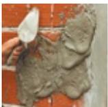
**Manual:** colocar con una cuchara la primera capa. **Proyectada:** proyectar en forma uniforme. Espesor máximo de la primera capa 20 mm. En ambos casos deja secar. Cuando el material haya tirado aplicar la segunda capa hasta conseguir el espesor deseado.
