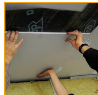
Colocar la 2ª placa de yeso. Apply the second dry wall. Placer la 2ème plaque. Colocar a 2ª placa de gesso.
