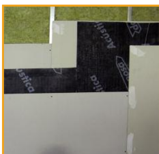
Pared sandwich acústico. Wall with acoustic sandwich. Mur avec sandwich acoustique. Parede sandwich acústico.
