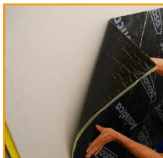
Presionar fuerte sobre la placa. Press the M.A.D. 4 against the wall. Appuyer avec force sur la M.A.D. 4. Pressionar forte sobre a placa.
