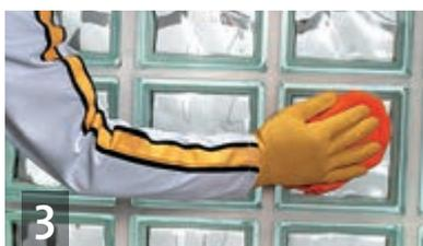
Retirar el exceso de material dejando un remarcado de las juntas. Rellenar faltantes si es necesario. Esperar aprox. 30 min. y efectuar el alisado final con un rejunter; terminar la limpieza con una esponja húmeda.
