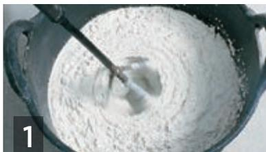
Amasar **weber.tec glass** con 1 L de agua limpia por cada 5 kg de material hasta obtener una pasta homogénea, firme y sin grumos. La mezcla puede ser manual o mecánica. Dejar reposar 5 min.
