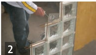
Extender **weber.tec glass** sobre los bloques de vidrio (ambas caras). Presionar hasta el aplastamiento del material. Utilizar espaciadores. Colocar varillas metálicas conforme a las recomendaciones del fabricante de bloques.
