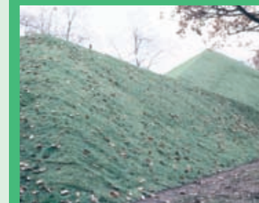
En este proyecto „Instalación piramidal Ernst Cramer” de la universidad de Hannover los paneles protectores para césped se utilizaron para estabilizar la pendiente y como protección frente a actos vandálicos.
