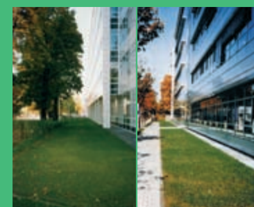
Un paso de bomberos configurado de esta manera reduce la temperatura exterior en la zona que circunda el edificio.
