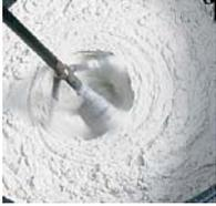
Amasar **weber.rev fino** con 4-5 litros de agua limpia por saco de 25 kg, manual o mecánicamente, hasta su total homogeneización.
