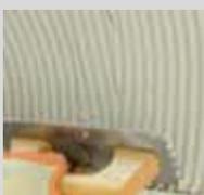
Dejar reposar la mezcla unos 2 minutos, extender sobre el soporte en paños pequeños (máximo 2 m<sup>2</sup>) y peinar con una llana dentada de 8x8 mm para regularizar el espesor de la aplicación.
