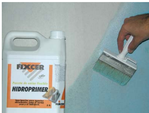
Imprimación con HIDROPRIMER.
