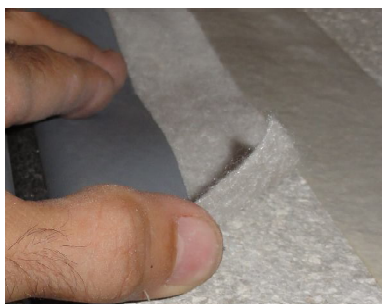
La cinta de pintor debe quedar a 2 cm de distancia de la banda.
