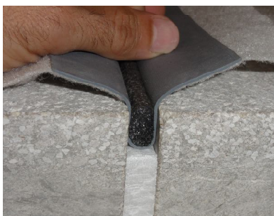
Situar la banda en el centro de la junta y formar un fuelle que llenaremos con SELLALASTIC FOAM.
