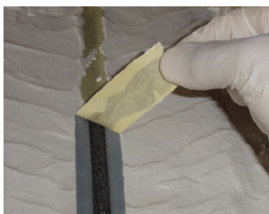
Retirar la cinta auto-adhesiva de ambos lados y también retirar la cinta central.
