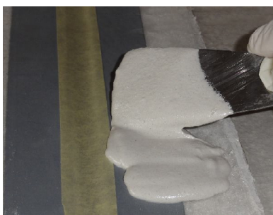
Pegar la banda y seguidamente colocar por encima más EPOXICOL y en ambos lados.
