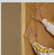
Colocar los paneles aislantes de lana mineral, ejerciendo cierta presión manual sobre el soporte, para garantizar el anclaje.
