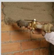
Amasar **weber.tec aislaterm** con 5 - 6 litros de agua limpia por saco, manualmente (a batidora) o mediante máquina de proyectar. Realizar un enfoscado del soporte de 3 a 5 mm de espesor (si es necesario, puede ser usado para rellenar pequeñas oquedades).
