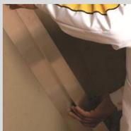
Regularizar la superficie aplicada mediante un regle.
