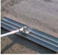
Extender el hormigón sobre el mallazo.
