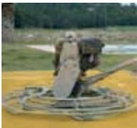
Fratasar toda la superficie hasta conseguir que **weber.floor pul** se integre en el hormigón, obteniendo un acabado liso.
