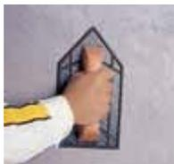
Una vez iniciado el endurecimiento, fratasar el material con un fratás de madera o plástico.
