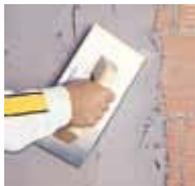
Amasar **weber.cal basic** con 4 - 5 litros de agua limpia por saco, manualmente (con batidor) o mediante máquina de proyectar, hasta su total homogeneización. Extender el producto con llana, dejando un espesor medio de 10 mm.
