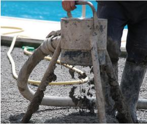
Amasar **Arlita® Leca® S** con un 10-20% de agua y un 15-30% de cemento, y verter o bombear\* sobre el soporte.
