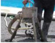
Amasar arcilla expandida **Arlita® Leca® dur** con un 10-20% de agua y un 15-30% de cemento, y verter o bombear\* sobre el soporte.
