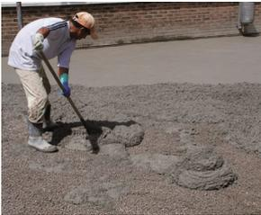
Extender el mortero con un espesor mínimo de 3 cm, regleándolo sobre maestras recuperables.
