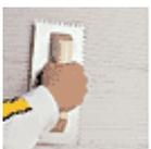
Extender sobre el soporte en paños de 1 m<sup>2</sup> aprox., peinando con una llana dentada para regularizar el espesor y proceder a la colocación.
