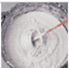
Colocar agua limpia en el balde, luego agregar **weber.col piscinas** paulatinamente (7 litros por bolsa aprox.). Mezclar manualmente o con batidor eléctrico (500 rpm) hasta obtener una pasta homogénea.
