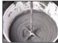
**B)** Remueva la mezcla con un batidor a baja velocidad (500 rpm) con el fin de obtener una pasta homogénea, evitando la formación de burbujas de aire en la masa.
