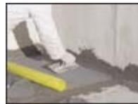
**C)** Aplique la mezcla con la ayuda de una espátula con un espesor máximo de 2 mm por capa. Aplique la segunda mano de producto cuando se haya endurecido previamente la primera (transcurridas alrededor de 4 horas).
