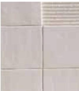
Colocar las baldosas-azulejos, presionando y moviendo de arriba abajo hasta conseguir el aplastamiento de los surcos del mortero cola.
