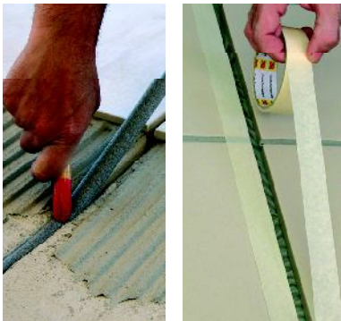
Embutir previamente SELLALASTIC FOAM; proteger los lados de la junta de dilatación con cinta de pintor.
